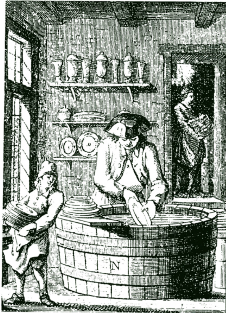
Kuva 6. Työntekijät lasittavat kastamalla keramiikkatehtaassa Delftissä. Kuva “Delft Pottery-maker” on faksimilia kaiverrus vuodelta 1794, (Gerrit Paape I De Plateelbakker nr 4312) (Fourest 1983, s. 2).
